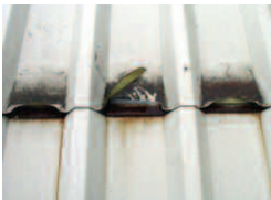
Dak van standaard plastisol op dompelverzinkt staal na 7 jaar.
